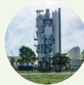
Werk Villmergen Asphalt Nordstrasse 6 5612 Villmergen
